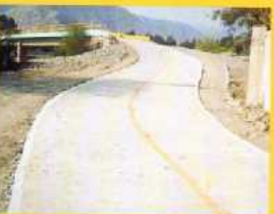
Nuevo acceso a puente peatonal
